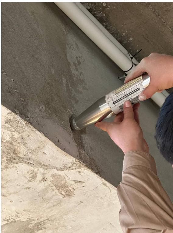
Фото 31. Определение прочности бетона на фрагменте монолитного железобетонного ригеля прибором Шмидт. Класс бетона В25
