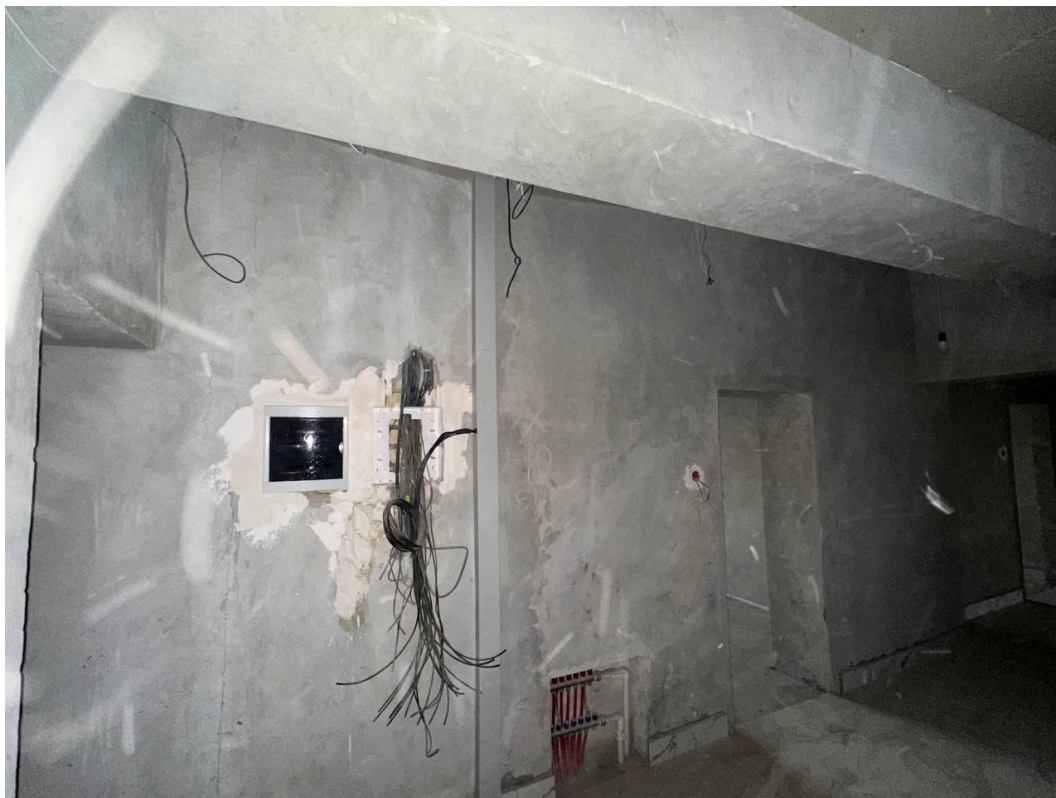
Фото 33. Фрагмент конструкции кирпичной стены. Обследования показали, что марка кирпичей М75.
