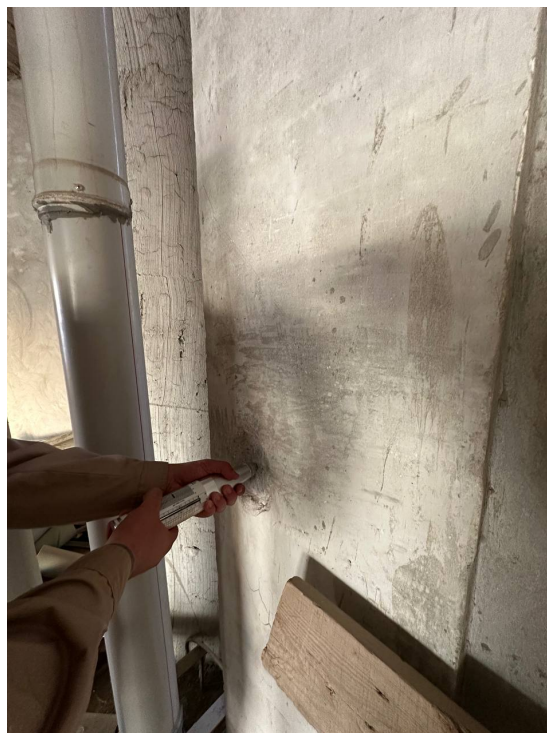
Фото 30. Определение прочности бетона на фрагменте монолитной железобетонной колонне прибором Шмидт. Класс бетона В25.
