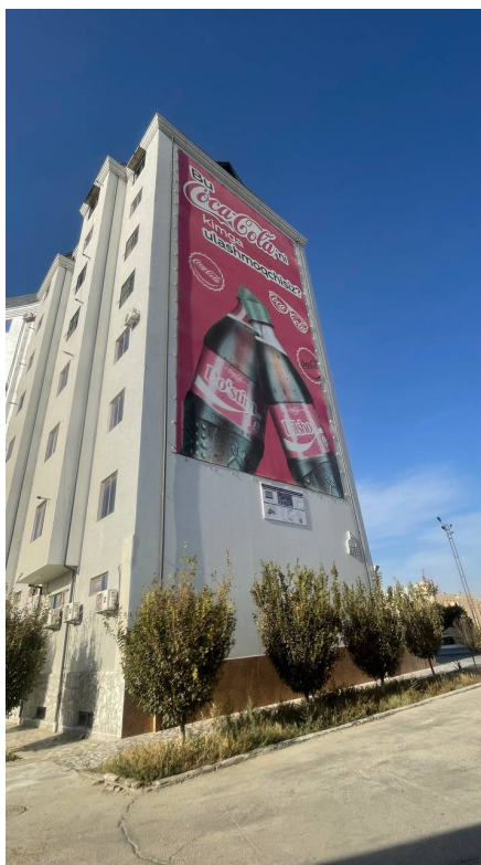
Фото 2. Общий вид бокового фасада жилого дома.
