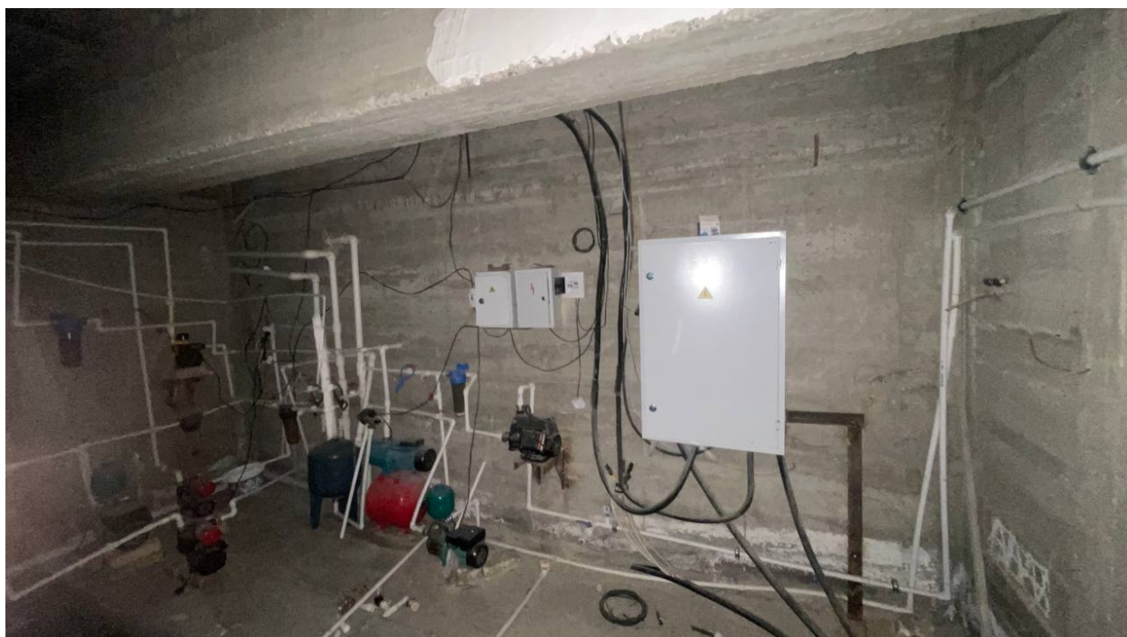
Фото 8. Общий вид монолитной железобетонной стены цокольного этажа блока Г по оси Б в осях 3-4. На стене не выполнена торкрет штукатурка что противоречит проекту по разработанному усилению
