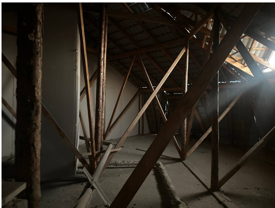
Фото 38. Фрагмент чердака. Показано устройство деревянных конструкций кровли. В конструкциях повреждения и дефекты не обнаружены.
