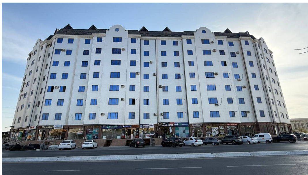
Фото 1. Общий вид передней части здания жилого дома всех блоков
