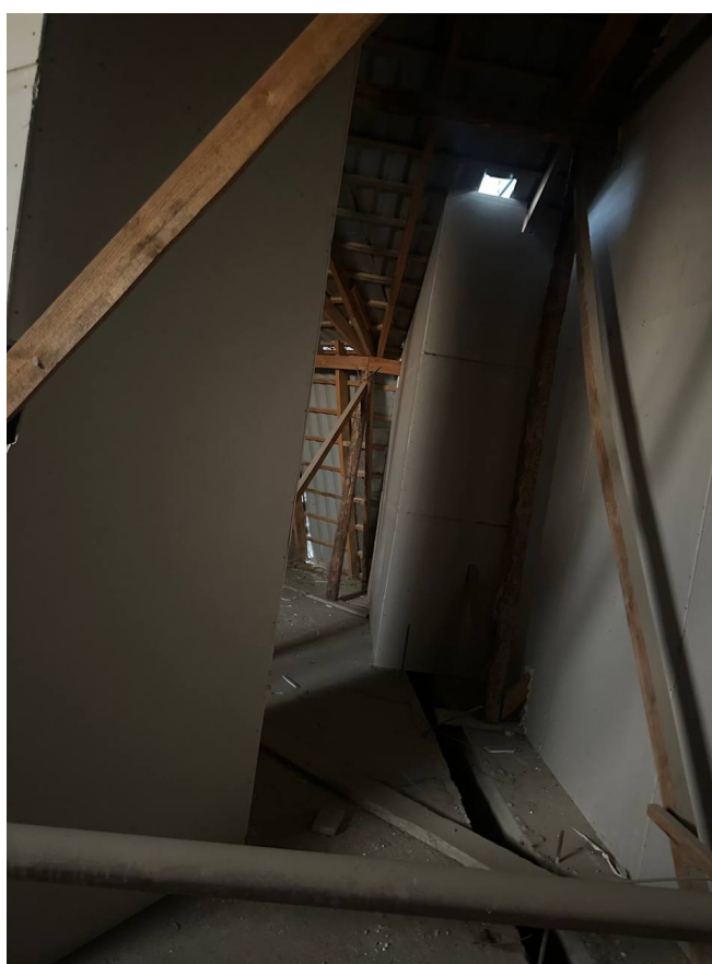
Фото 40. Фрагмент чердака. Показано устройство деревянных конструкций кровли. В конструкциях повреждения и дефекты не обнаружены.
