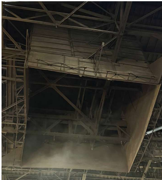
60-rasm. Gaz chiqarish tizimining sex ichidagi qismi – sirt va metall karkas holati Manba: joyida o‘tkazilgan texnik ko‘rik davomida olingan surat.
