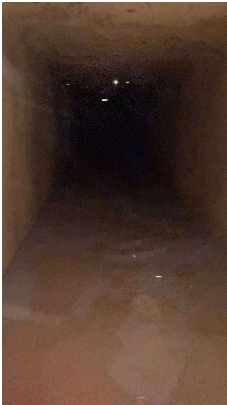
48-rasm. Gazoxod trubasining ichki kanali holati (ko‘rik jarayonidagi umumiy ko‘rinish)
