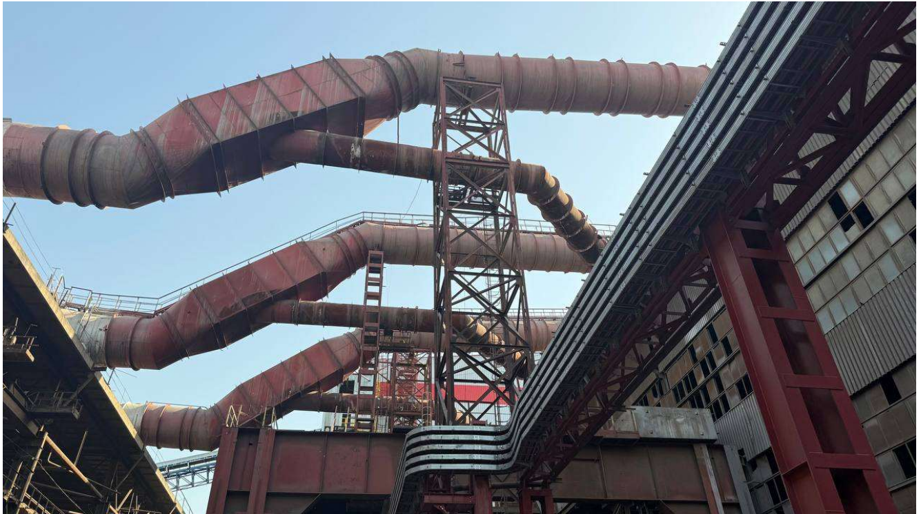
1-rasm. Elektrda po‘lat eritish bo‘limi (EPEB) gaz tozalash tizimining gazoxod quvurlari va metall tayanch konstruksiyalari umumiy ko‘rinishi.
