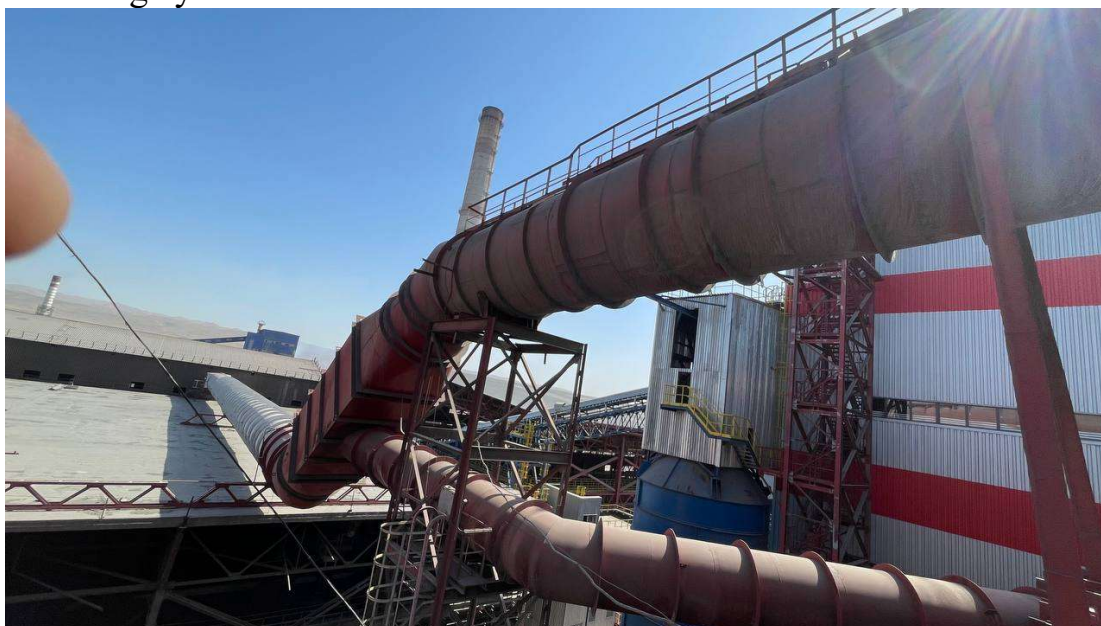
56-rasm. Gazoxod tizimining vertikal va gorizontal tarmoqlari (yuqori qismdan ko‘rinish)
