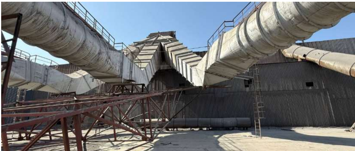
53-rasm. Gazoxod tizimining umumiy ko'rinishi (tashqi qismi)
