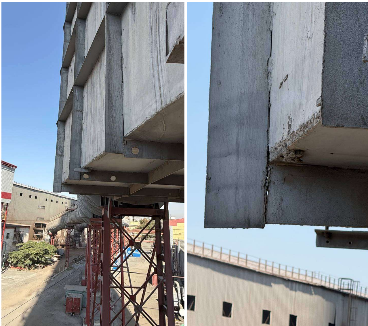
27-rasm. Gazoxod metall qoplamasining pastki va yon birikma qismi ko‘rinishi Manba: joyida o‘tkazilgan texnik ko‘rik davomida olingan surat.
