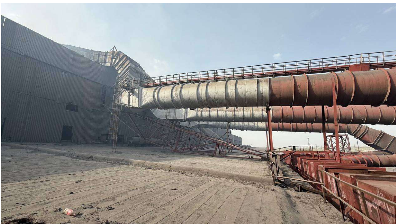
3-rasm. Gaz tozalash yo‘li (gazoxod)ning Elektrda po‘lat eritish tsexi bilan tutashgan qismi, tayanch metall konstruksiyalar va issiqlikka chidamli po‘lat quvurlar ko‘rinishi.
