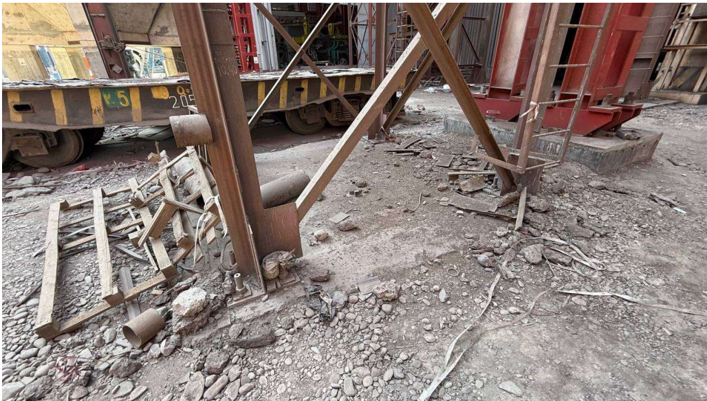
16-rasm. Tayanch metall konstruksiyaning poydevorga biriktirilgan qismi ko'rinishi.
