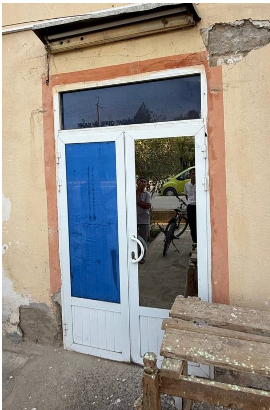
Фото 1. Общий вид установленной в открытом проеме двери с наружной стороны.
