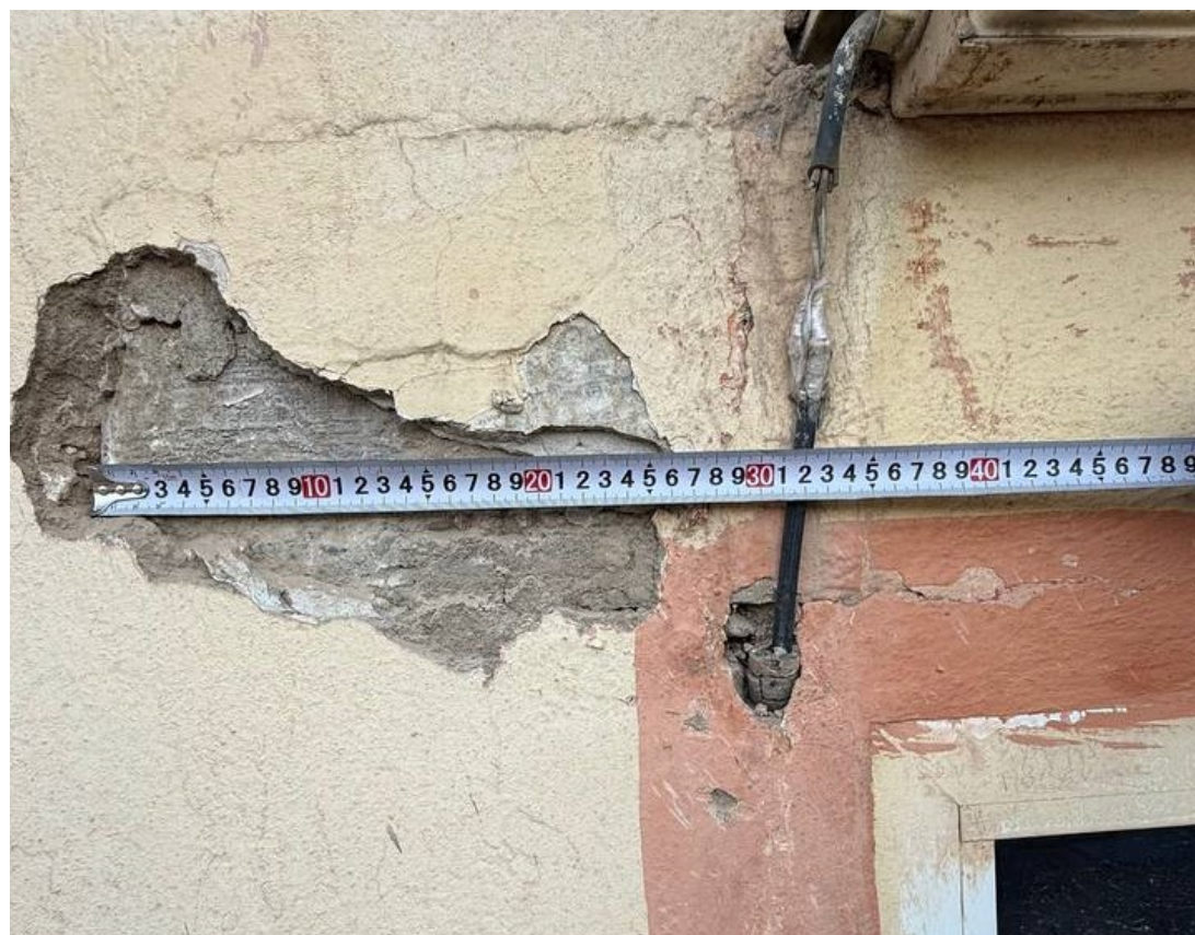
Фото 3. Фрагмент перемычки над входной дверью, перемычка от двери по фото А) 450мм и по фото Б) 350мм, состояние удовлетворительная.
