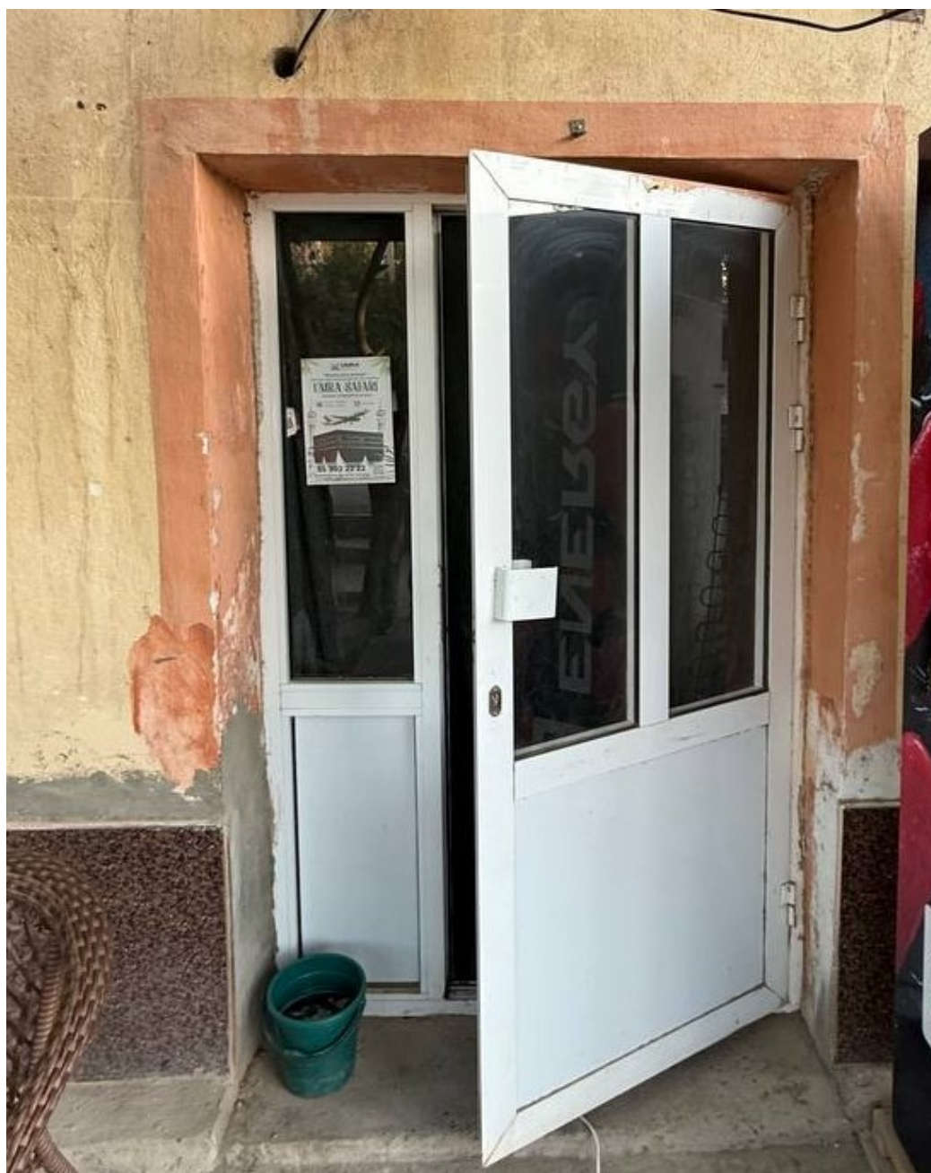
Фото 1. Общий вид установленной в открытом проеме двери с наружной стороны.
