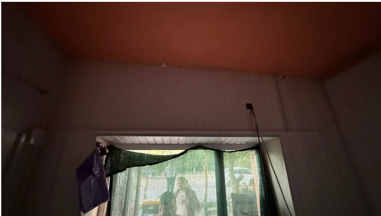
Фото 2. Фрагмент перемычки входной двери, состояние удовлетворительная.
