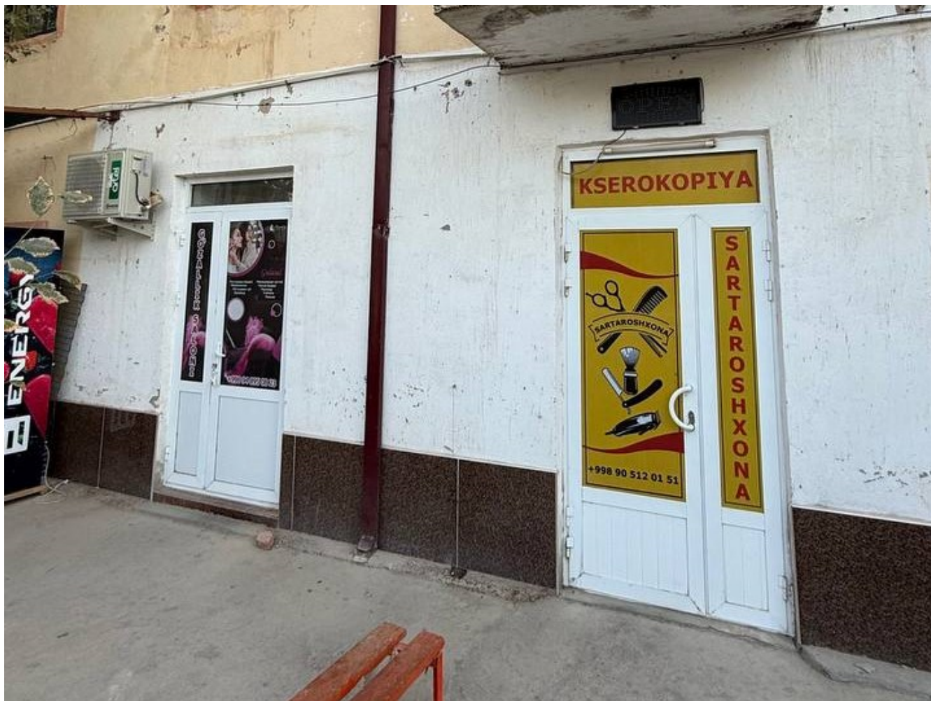
Фото 1. Общий вид установленной в открытом проеме двери с наружной стороны.
