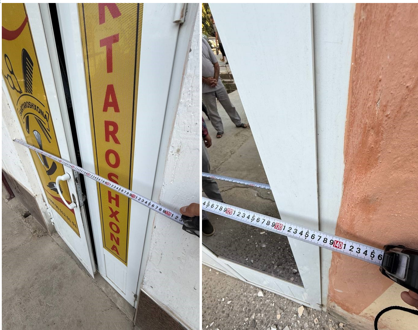
Фото 2. Ширина дверей №1 и №2, расстояние №1 двери 120мм и №2 двери 140мм, состояние этих дверей удовлетворительная.
