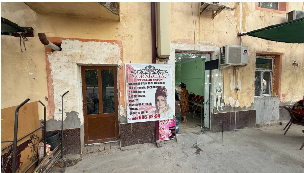
Фото 1. Общий вид установленной в открытом проеме двери с наружной стороны.
